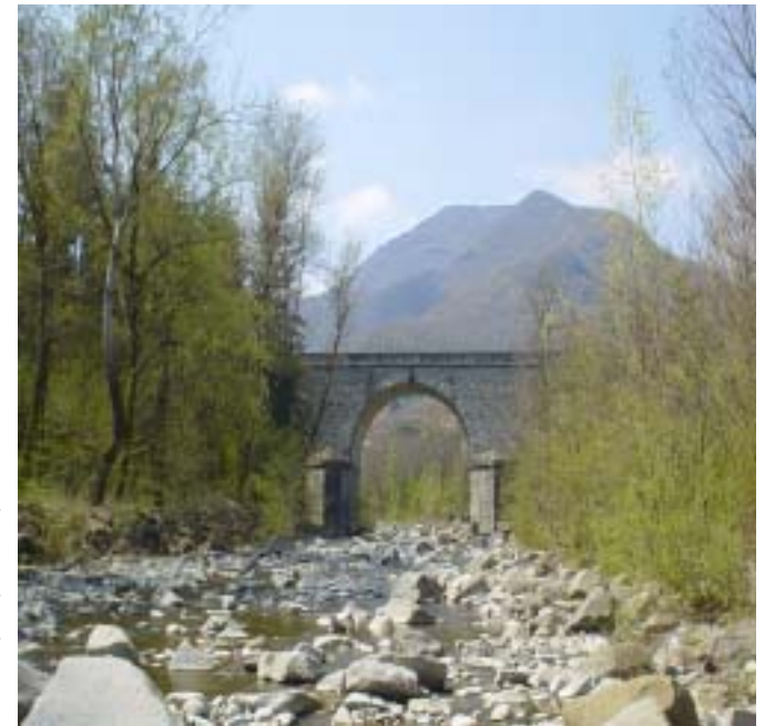
Veduta del ponte sul Reno
